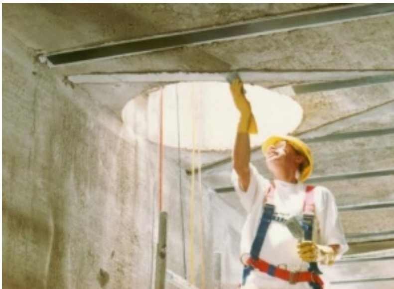
Bild 1: CFK Lamellenverstärkung im RRB Offenbach
