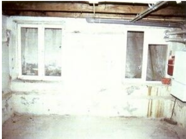
Abb. 1: Reihenhaushausgruppe Amsterdam-Süd. Gesamtansicht Keller.
