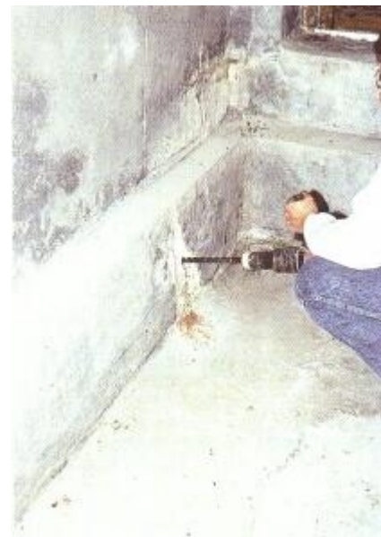
Abb. 2: Kontrollbohrung mehrere Jahre nach Acrylat-Verfüllung: Trockenlegung des Mauerwerks. Gelpartikel in Konstruktionshohlräumen
