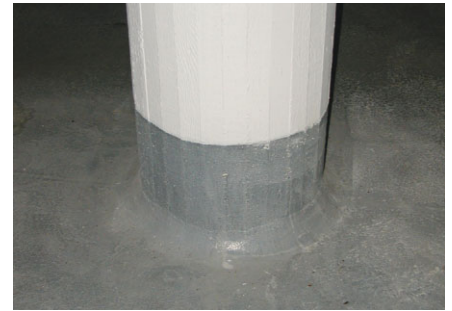
Bild 2. Stützenanschluß mit Hohlkehle
