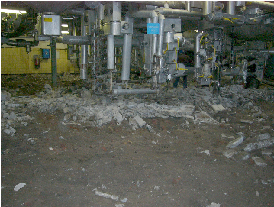
Bild 2: Abbrucharbeiten im Produktionsbereich
